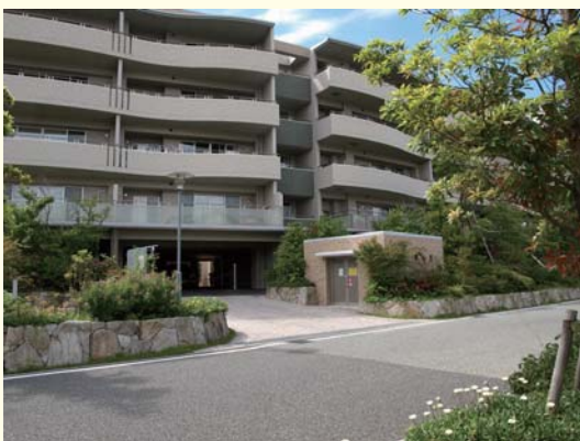
駐車場出入口、ごみ置場を区画道路に面して配置し、周囲を緑化など修景した事例
